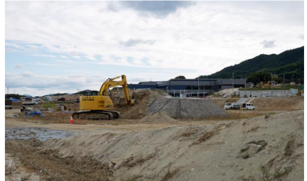
▲道路整備現場イメージ
